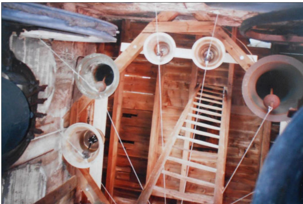
Le montage des cloches dans le clocher - Juin 1994
