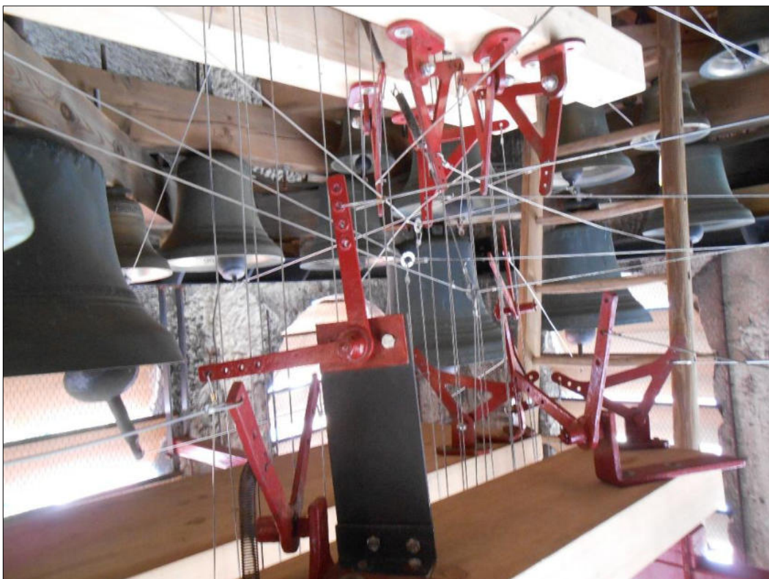
Les équerres et les renvois assurant la traction des battants depuis l'installation du nouveau clavier en 2015
