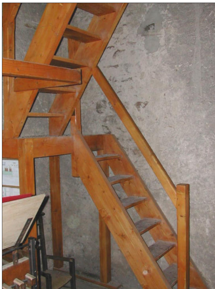
L'escalier du carillon, installé en 1997
