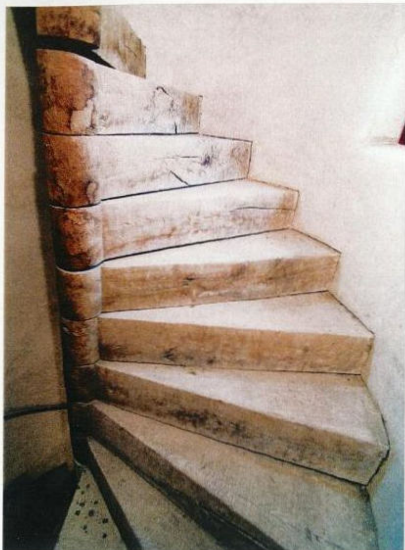
Tour Carrée (intérieur) – Photo JL. Bessenay
