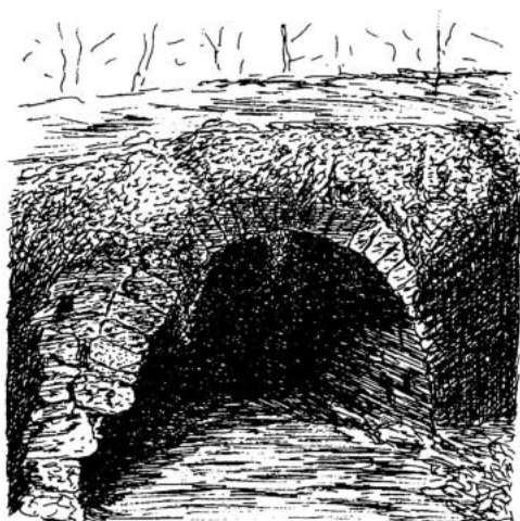
PONT DE LA BARGE
