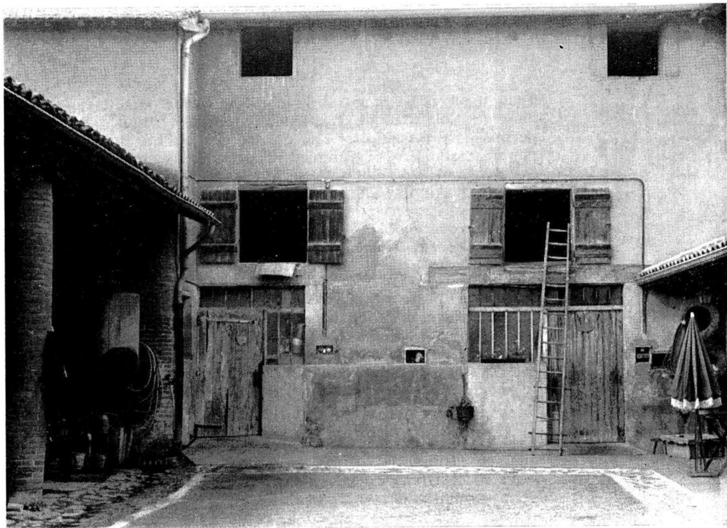
Ferme du Rat, bâtiments d'exploitation.
